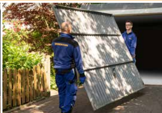
Ausbau und umweltgerechte Entsorgung
